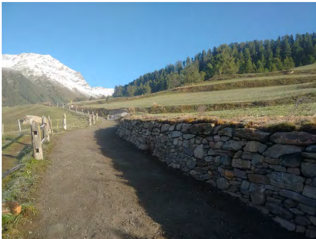
Abb. 3: Teilstück der renovierten Trockensteinmauer entlang des Wanderwegs ins Val Tuoi
