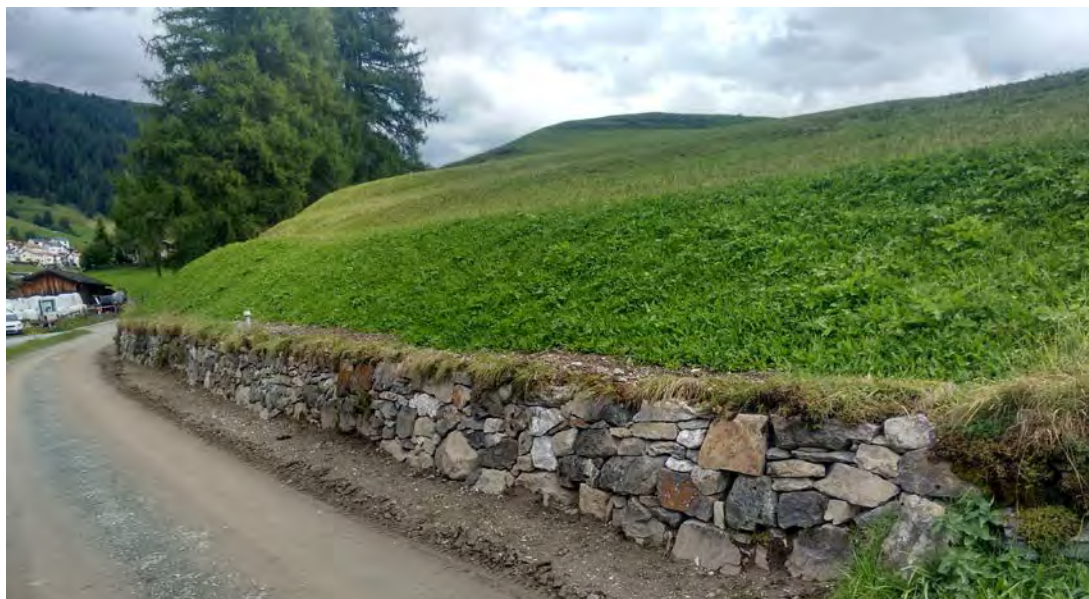
Abb. 2: Trockensteinmauer in Ftan wiederinstandgestellt
