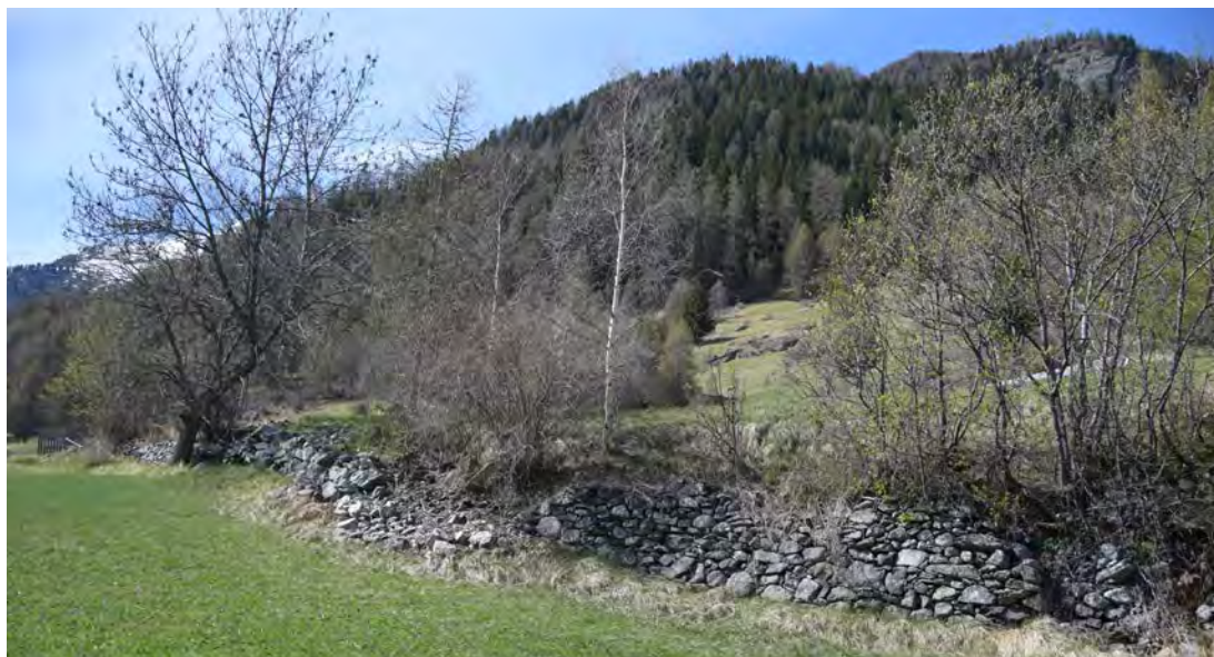
Abb. 6: Trockensteinmauer in Lavin vor dem Wiederaufbau
