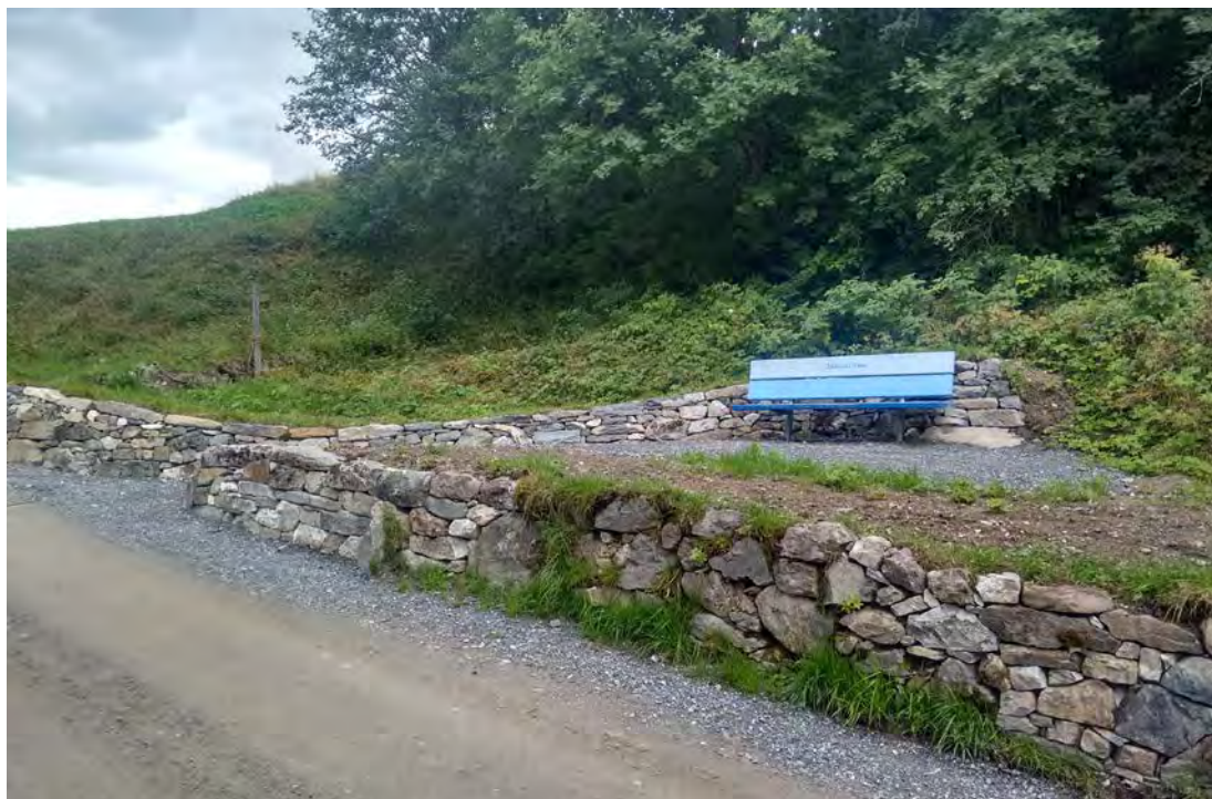
Abb. 1: Trockensteinmauer in Ftan nach dem Wiederaufbau durch Zivildienstleistende
