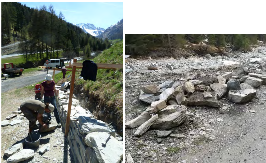
Abb. 5: Trockensteinmauerwiederaufbau und ausgesuchte Steine für die Trockensteinmauer in Samnaun
